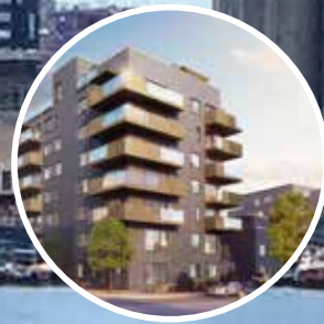
Här byggs Brf Styrbord.
